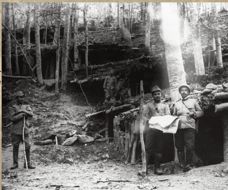
Stabilirea punctelor de stație
