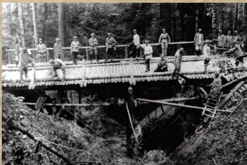
Repararea unui pod de către geniști români
