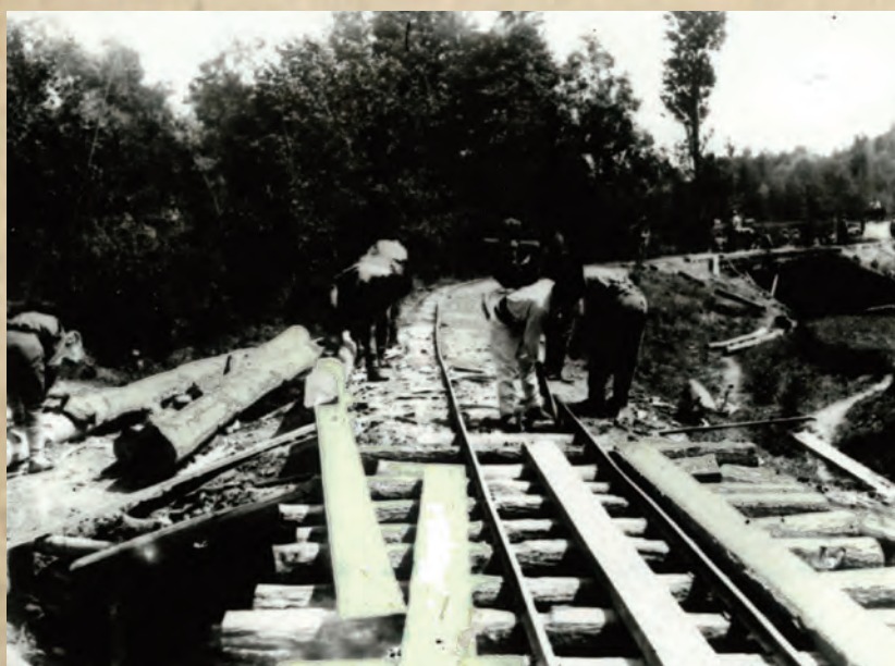
Construcția unei căi ferate
